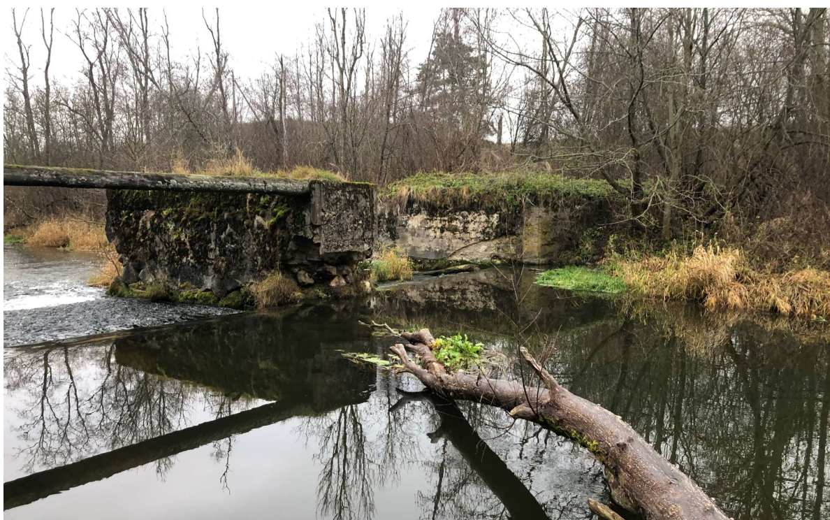
Foto 4. Lagunenud Varangu kalda- ja jõesambad 14.12.2020
